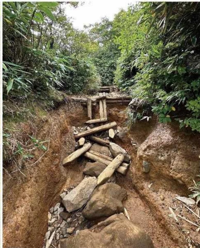
※2024年には1年間で50cm以上の高さの土砂が流された場所もある(写真左)。歩きにくいばかりか、大雨により登山道上で土石流が発生する可能性のあるエリアも存在する。
