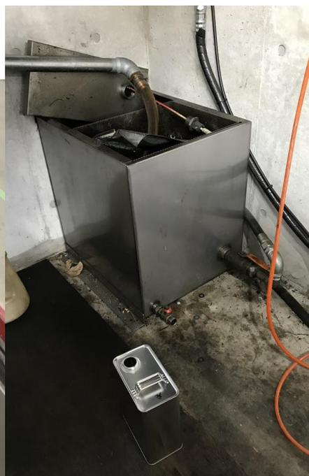
図 4-1-3 廃油抜き取り中継タンク
