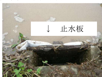
止水板の設置
