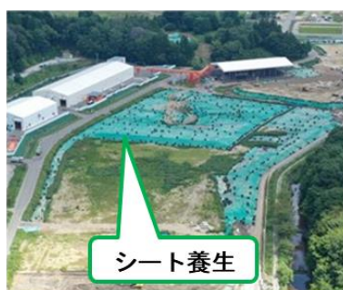
シート養生状況
