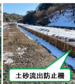
土砂流出防止柵設置状況
