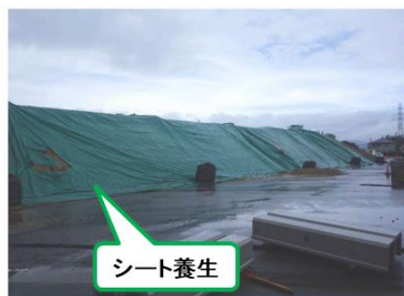
法面部シート養生設置状況
