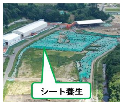
シート養生状況
