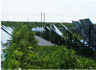
不十分な管理で放置されたパネル
