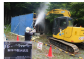
被災家屋等の解体の様子
