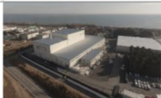
大熊町の仮設焼却施設(2017年12月)
