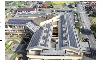
西伯病院における設置状況 (写真：南部だんだんエネルギー株式会社提供)
