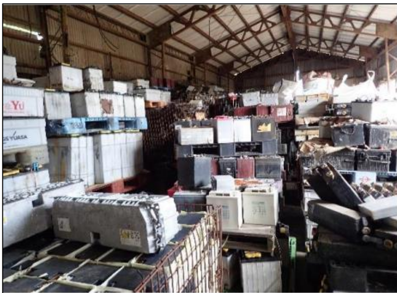
大量の廃鉛蓄電池の屋内保管
