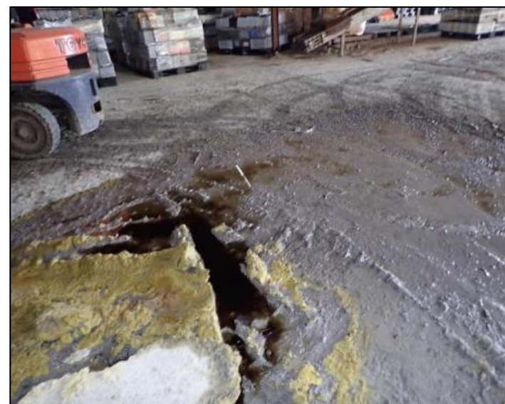
地面の汚水の状態
