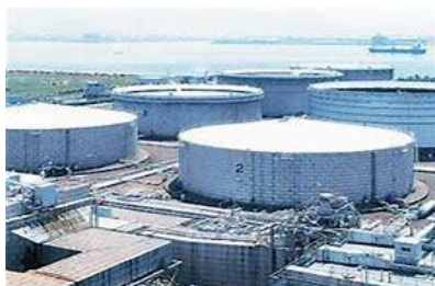
石油貯蔵タンク
