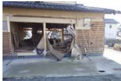
壁板・床板の排出
