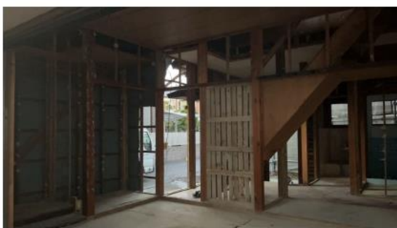
図15 ①建築設備撤去～③内・外部建具撤去の様子
