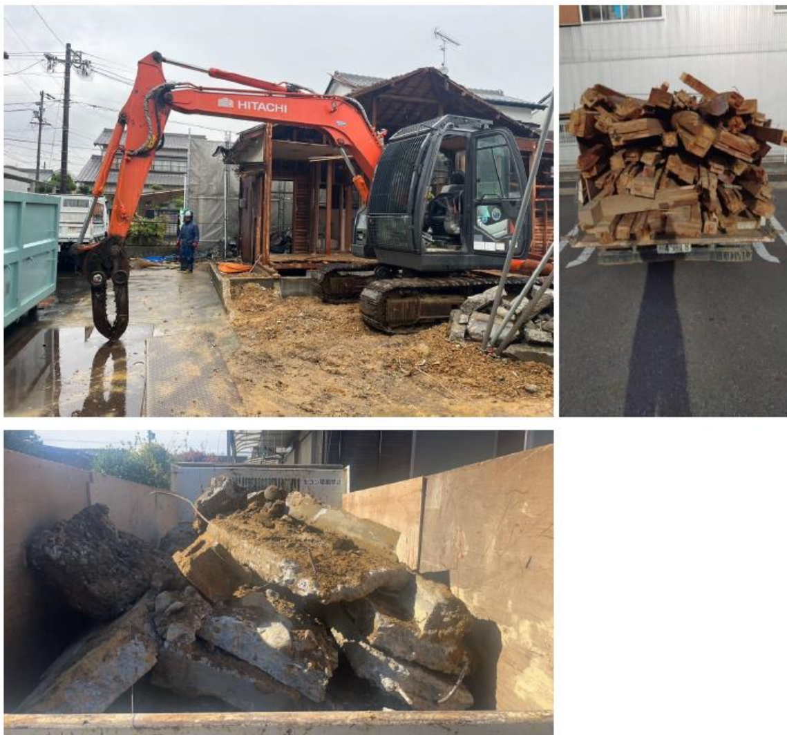
図16 ⑦外装材、上部構造部分解体～⑧基礎等解体の様子
