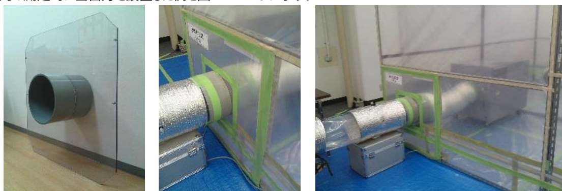
図4.14.14 排気ダクト貫通パネル例
