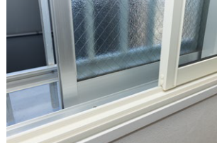
全住戸の内窓設置を実施
