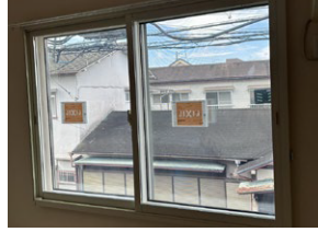
主居室の南側に内窓設置
