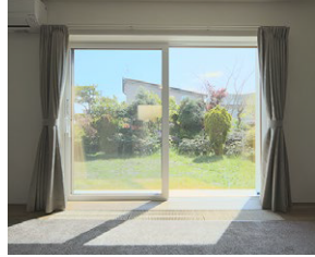
外窓交換(はつり工法)を実施
