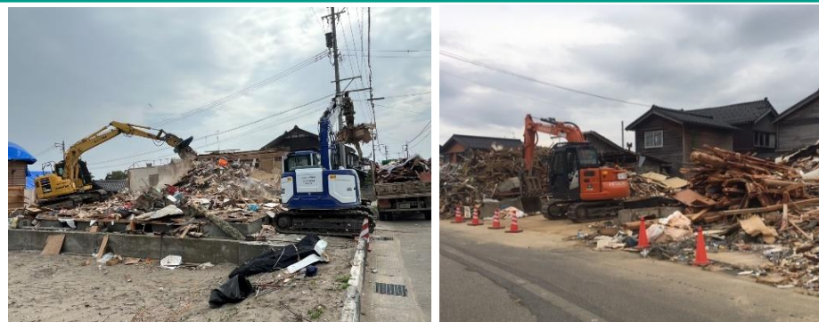
倒壊した家屋等の解体・撤去
