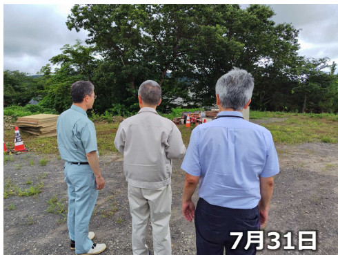
由利本荘市での仮置場の状況確認
