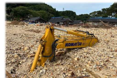
豪雨直後の珠洲市の解体現場例
