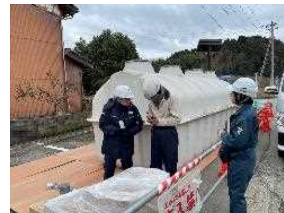
能登町での浄化槽の状況確認
