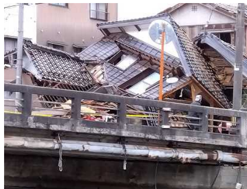
石川県穴水町 民家の被害 （1 月 5 日）
