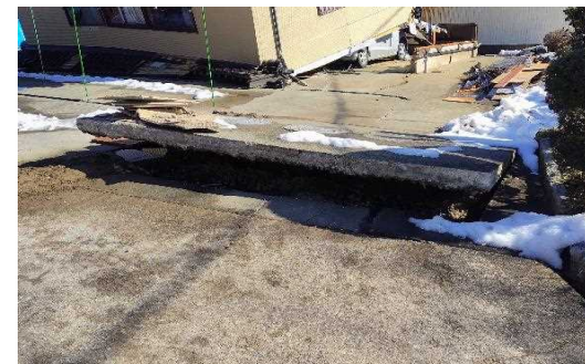
地震により浮き上がった浄化槽（画像は珠洲市内の例）
