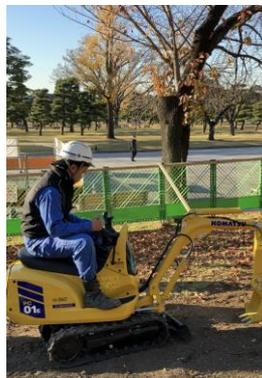
歩道のベンチ再設置に向けた掘削土の埋戻作業
