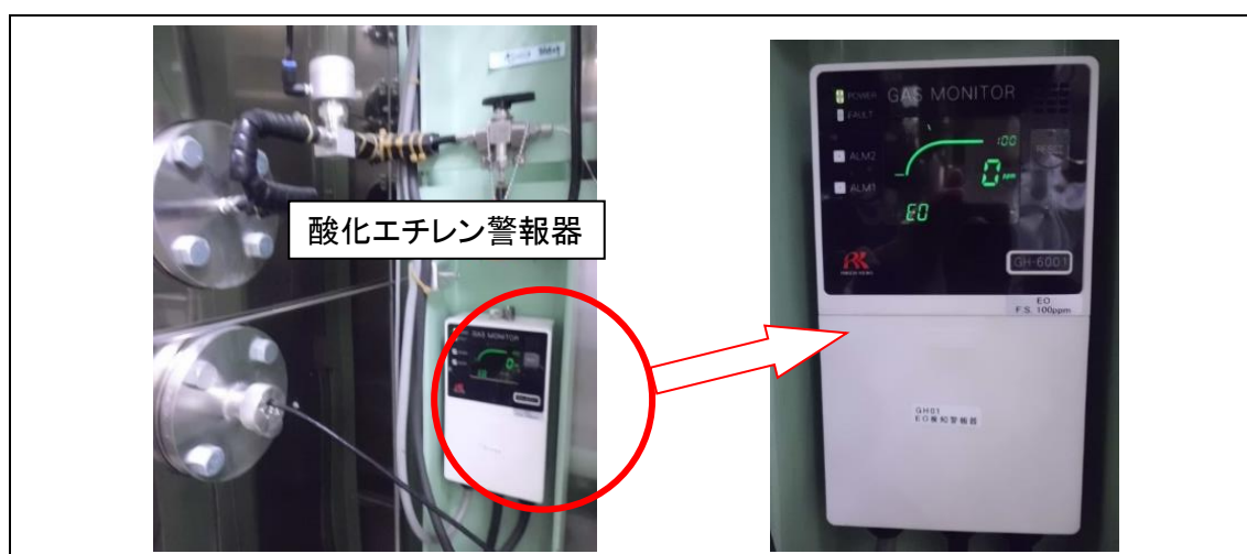
図 13 酸化エチレン警報機の設置例
