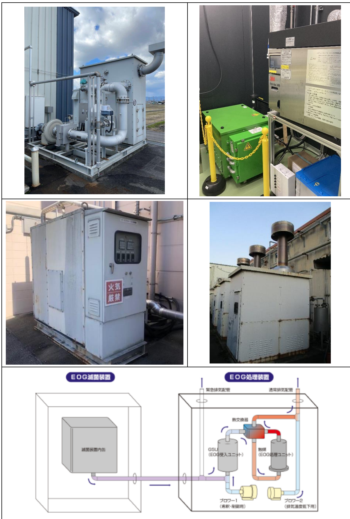
図 12 排ガス処理装置の設置例(触媒燃焼)
