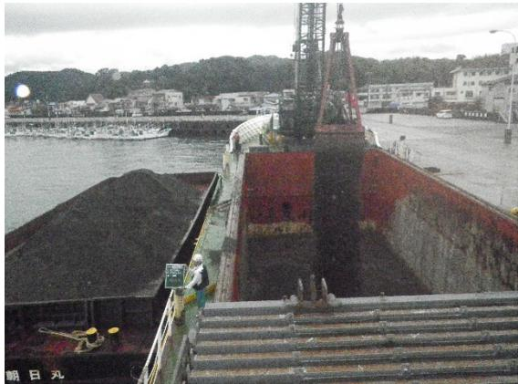
土運船からガット船に浚渫土砂を積み替え
