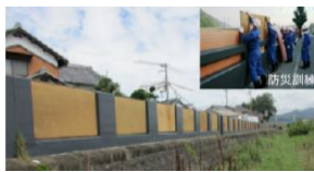
自主防災活動による量堤設置 (埴保川水系、たつの市)
