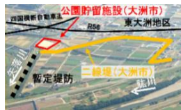
二線堤の保全・拡充 (牴川水系、大洲市)
