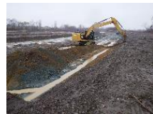
河道掘削 (石狩川水系、北海道開発局)
