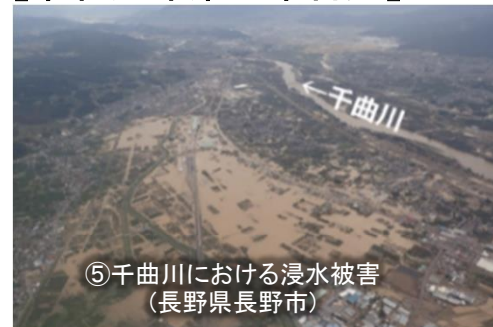
【令和元年東日本台風】
