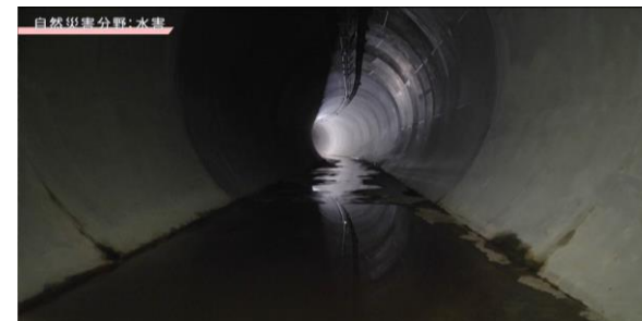
豪雨災害に備えた放水路トンネル
