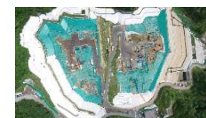
特定廃棄物埋立処分場
