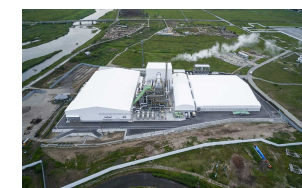
浪江町 仮設焼却施設
