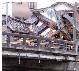
石川県穴水町 民家の被害
