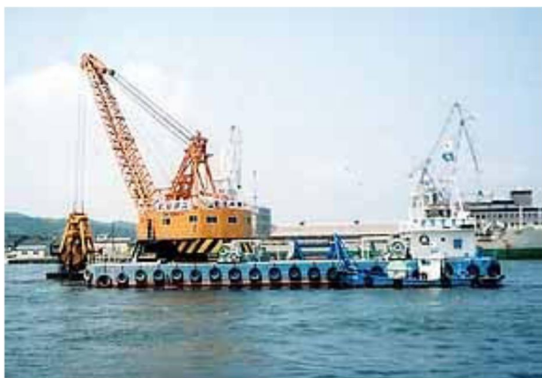
↑ グラブ浚渫船を用いた浚渫作業
