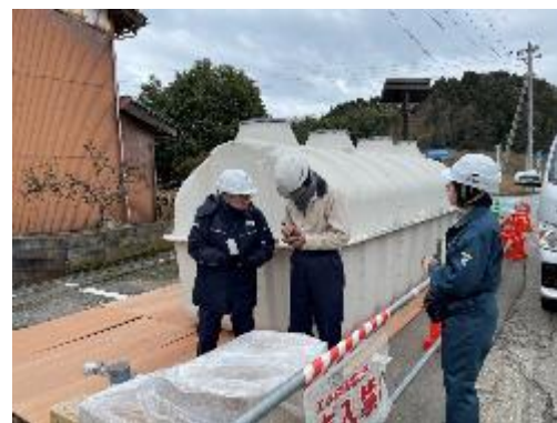
能登町での浄化槽の状況確認
