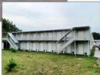
コンテナハウス
