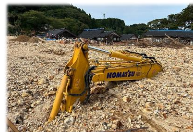
豪雨直後の珠洲市の解体現場例
