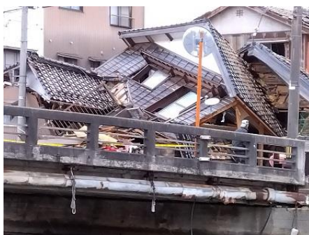
石川県穴水町 民家の被害 （1月5日）
