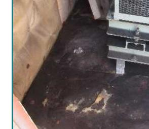
↑装置内部は老朽化が進み、雨水侵入による素材の劣化やモーター異常、配管の漏水等も生じている。
