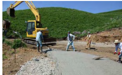
地震により損壊した管理道の修繕
