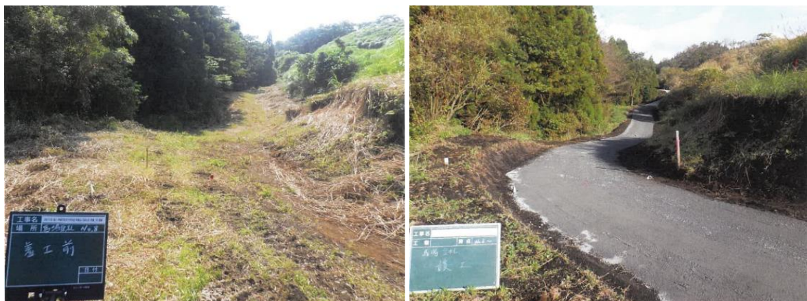
写真３－１ 令和３年度に整備した馬場豆乳牧野における管理道兼防火帯 （左：工事前、右：工事後）
