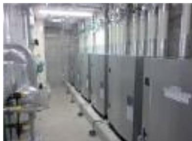
ピーク負荷時は地中熱ヒートポンプと吸収式冷温機との同時運転
