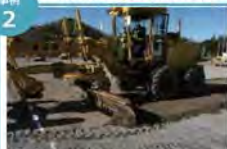
●校庭表土の削り取り
