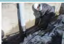
●側溝の汚泥の除去
