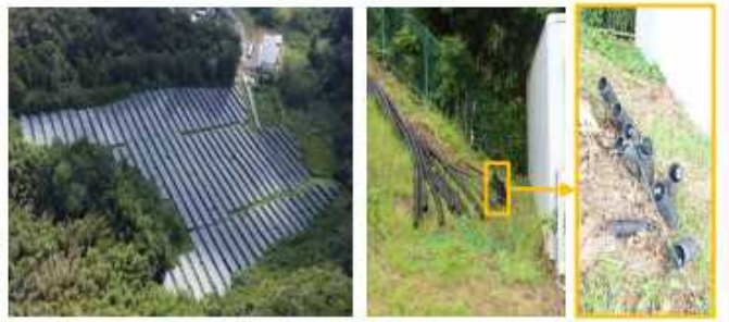
被害に遭った太陽光発電施設
