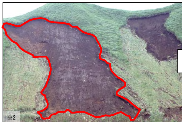
1990 年豪雨による表層の崩落
