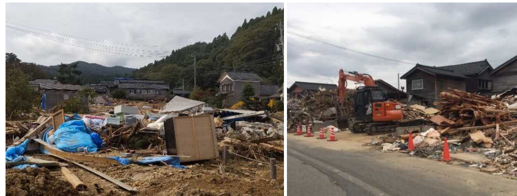
倒壊した家屋等の解体、撤去
