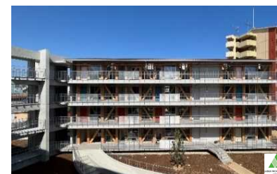
徳島県新浜町団地営住宅2号棟 (徳島県徳島市、令和5年2月竣工)
