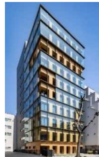
純木造11階建て・研修施設 (2022年竣工)
