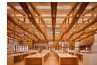
木造(一部RC造)2階建て 公共施設(2021年竣工)
