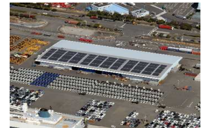
横浜港における太陽光発電設備
