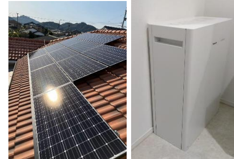
戸建住宅への太陽光パネルと蓄電池の設置
