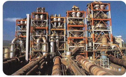
セメント製造施設
