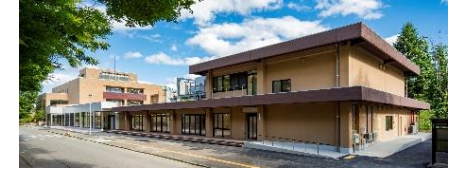
ナレッジコモンズ(令和3年度採択)(Nearly ZEB改修)
