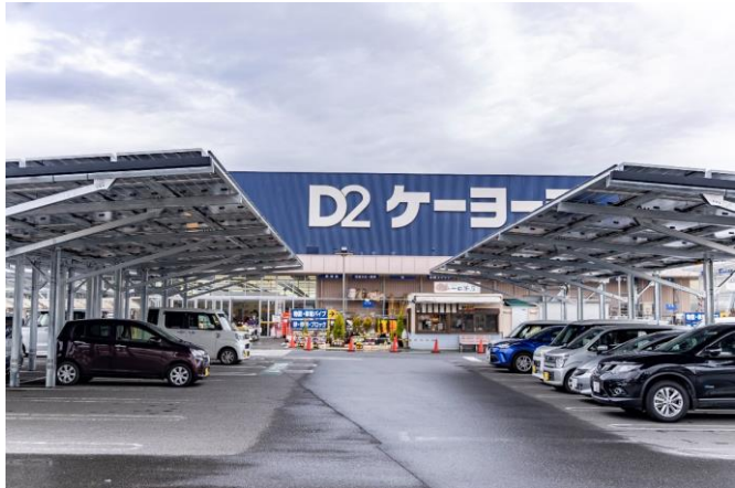
写真 ソーラーカーポート設置状況
