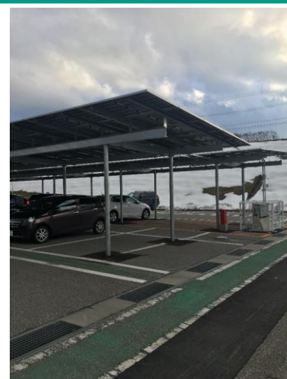
写真 ソーラーカーポート設置状況
