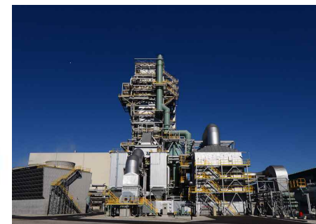
バイオマス発電施設
