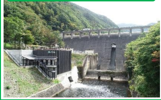
24 越百(こすも)のしずく発電所 (令和4年7月着工)
