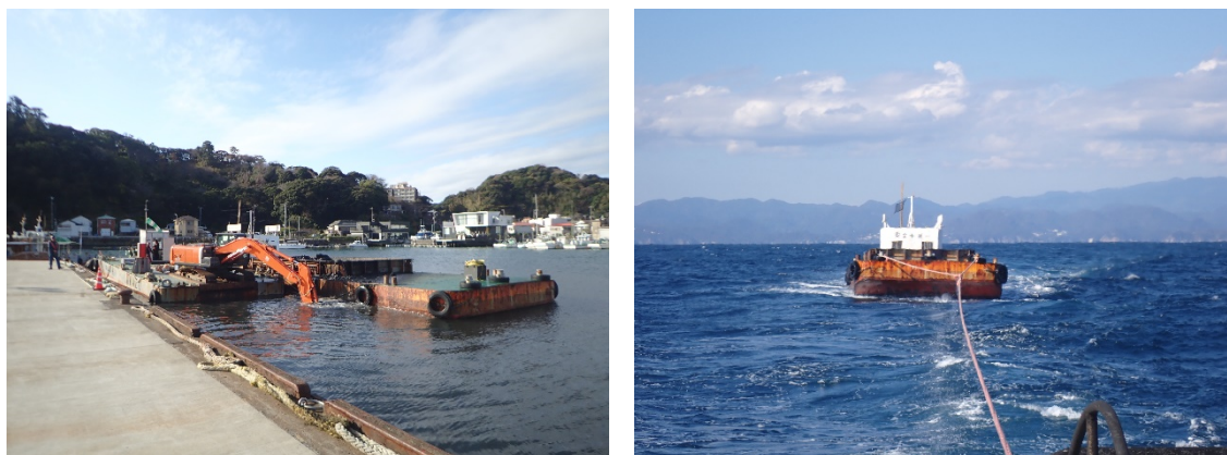
図－3.1 浚渫作業（左）及び運搬作業（右）状況
