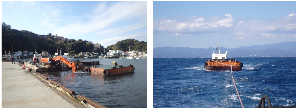
図－3.1 浚渫作業（左）及び運搬作業（右）状況
