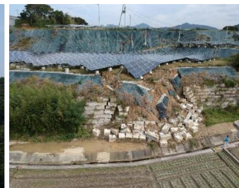
法面保護工が崩れて流出した事例
