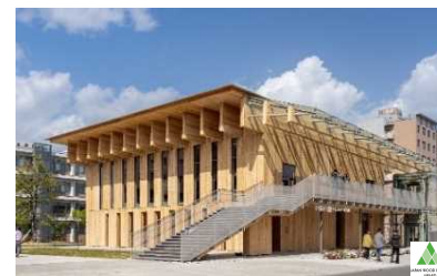
岡山大学共育共創コンズ(OUX:オークス) (岡山県岡山市、令和5年1月竣工)
