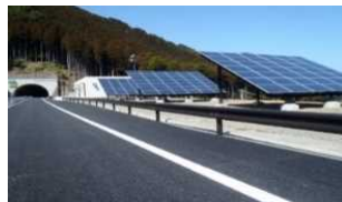
道路における太陽光発電の活用
