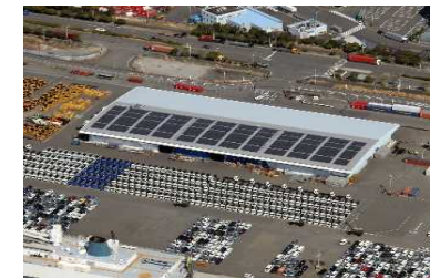
横浜港における太陽光発電設備
