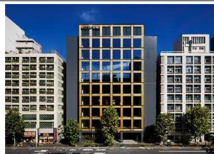
地下1階・地上9階建て混構造オフィスビル
