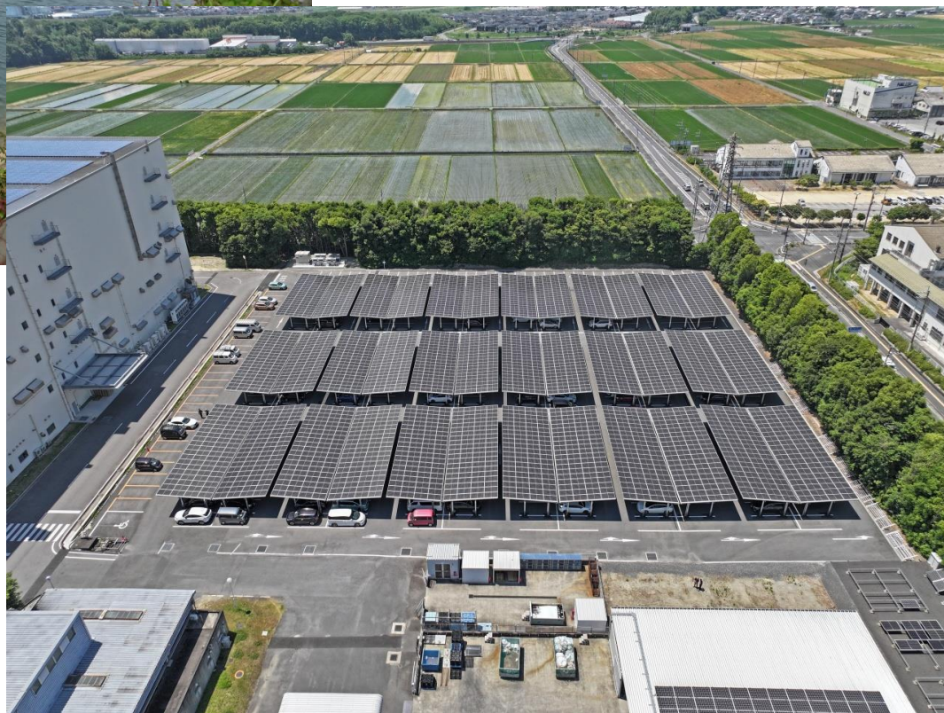
ソーラーカーポート 京セラ 滋賀野洲工場
