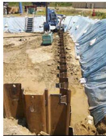
図 8-20 遮水壁（鋼矢板）の打設状況
