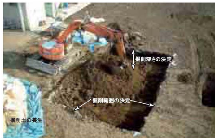
図 8-14 掘削除去の概況写真
