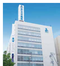
あなぶきセントラルビル
