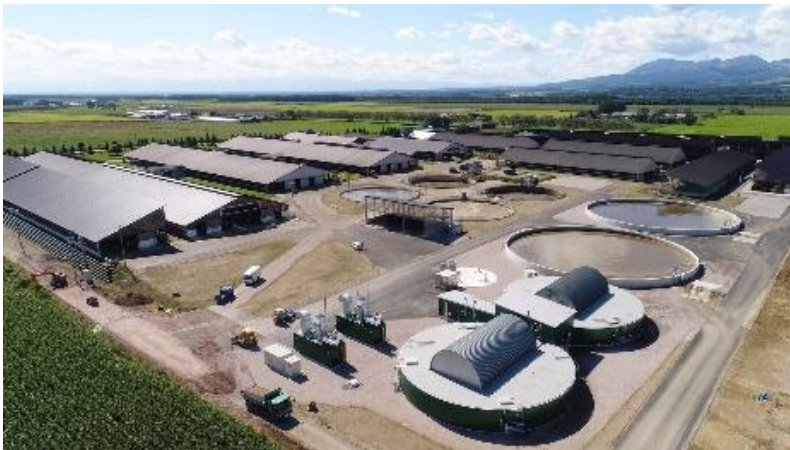
バイオガスプラント
